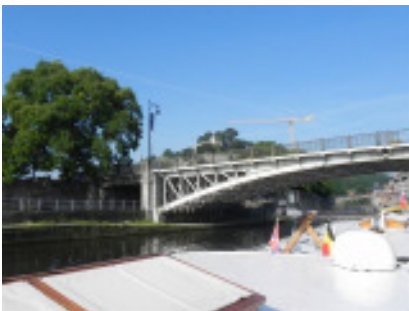
Einfahrt von der Maas in die Sambre.
