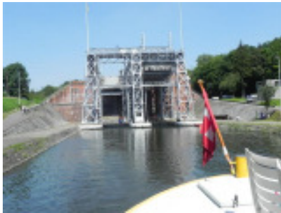
Hier sieht man den Zylinder, welcher das Bassin mit dem Schiff drin anhebt.
