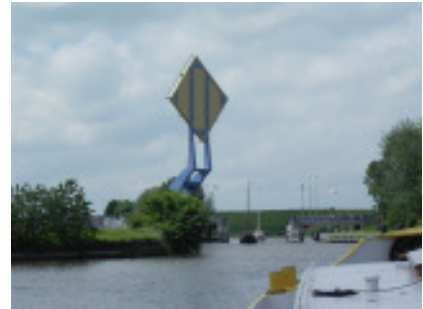
Nach kurzem Aufenthalt in Leeuwarden schon wieder auf der Rückfahrt: die sogenannte Fliegenklappen-Brücke.
