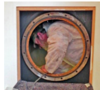
Roy kriecht da hinein und streicht den Tank neu mit Zement aus.
