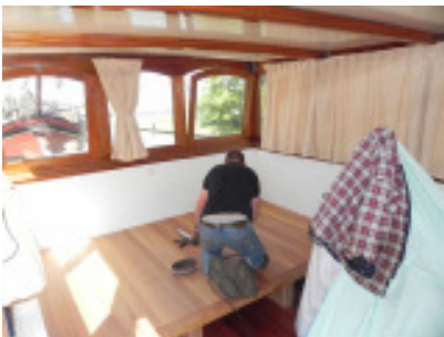
Das Podest in unserem Steuerhaus wird fertig gestellt.
