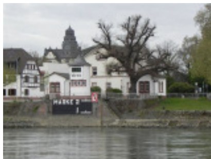
Der Pegel Worms mit den beiden Hochwassermarken.
