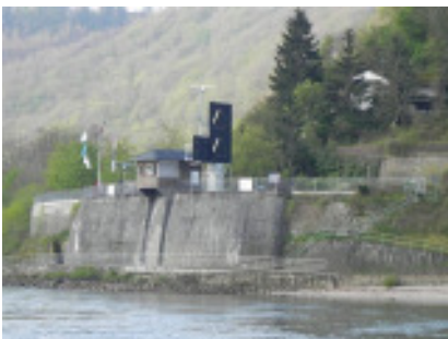
← Die Lichtwarschau in der Gebirgsstrecke: Anzeiger der zu Tal fahrenden Schiffe für die Bergfahrt.
