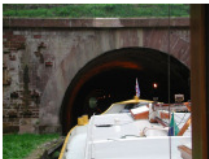
Einfahrt in den ersten Tunnel.
