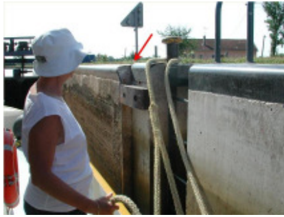
Schleusenreparatur (Pfeil) à la mode des VNF!
